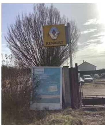
Figure 89 : Enseignes scellées au sol et installées directement sur le sol souffrant d'un mauvais état (enseignes a priori non conformes au RNP), Amanvillers et Châtel-Saint-Germain, printemps 2021
