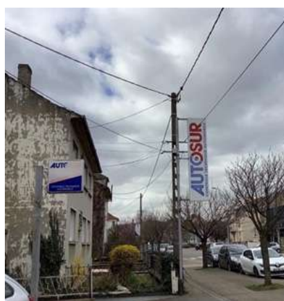
Figure 90 : Enseigne scellée au sol ne respectant le recul minimal par rapport aux limites séparatives (enseignes a priori non conformes au RNP), Scy-Chazelles et Metz, printemps 2021
