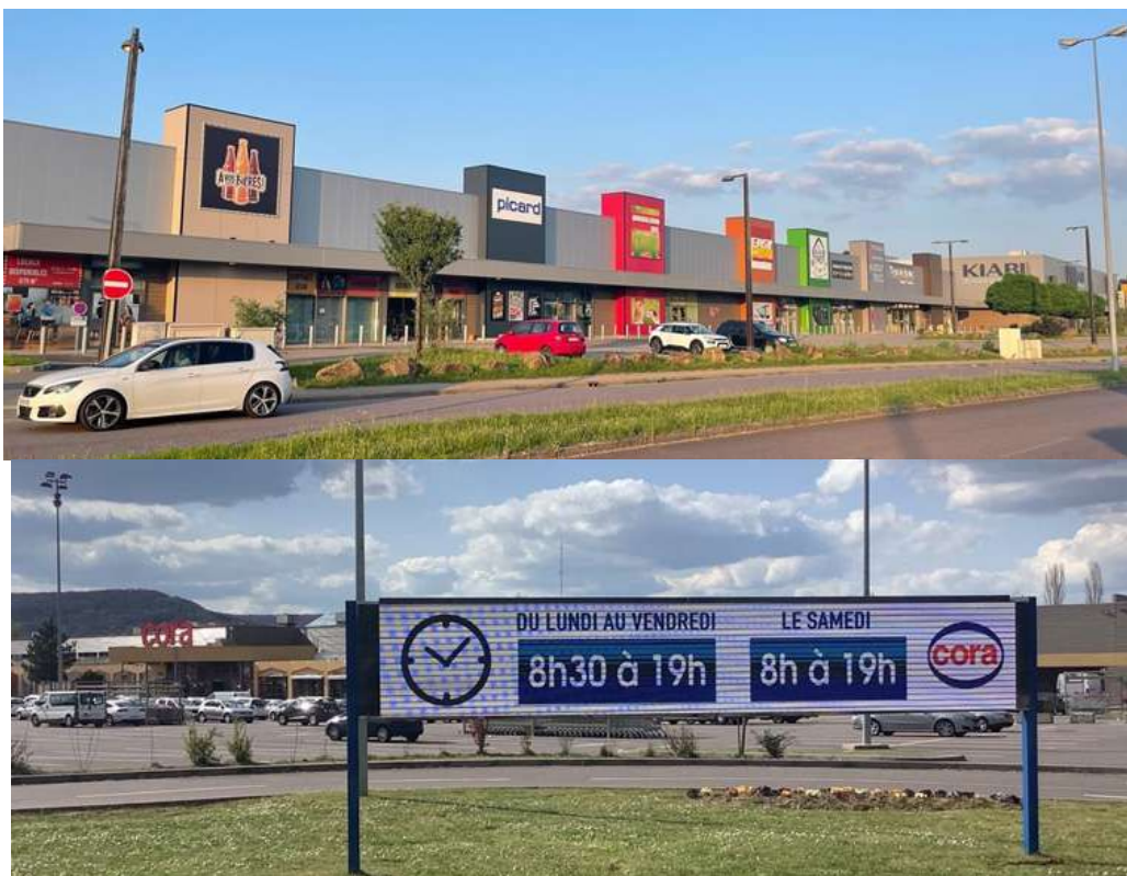
Figures 118 : Enseignes imposantes dans la partie « ancienne » d'Actisud, Moulins-lès-Metz, été 2021
