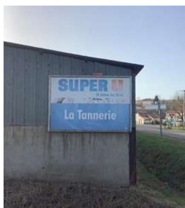
Figures 54 : Dispositifs publicitaires muraux souffrant d'un mauvais état rendant leur lisibilité difficile (supports a priori non conformes au RNP), Saulny et Nouilly, printemps 2021
