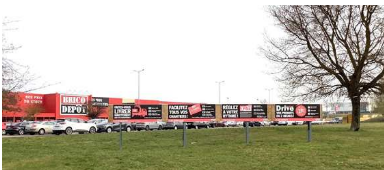
Figure 89 : Enseigne scellée au sol d'une largeur de près de 10 mètres (enseignes a priori non conformes au RNP), Metz, printemps 2021
