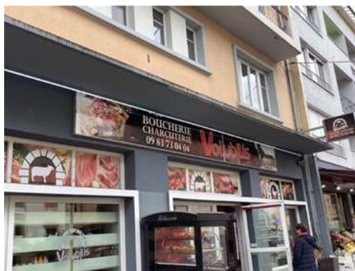
Figure 79 : Activité disposant d'une surface cumulée excessive de ses enseignes en façade (enseignes a priori non conformes au RNP), Montigny-lès-Metz, printemps 2021
