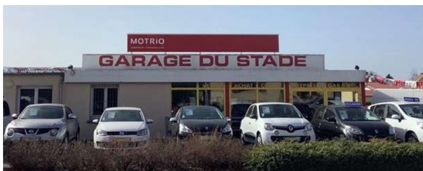
Figure 100 : Enseigne sur toiture sur un panneau plein sans lettres découpées (enseignes a priori non conformes au RNP), Amanvillers, printemps 2021
