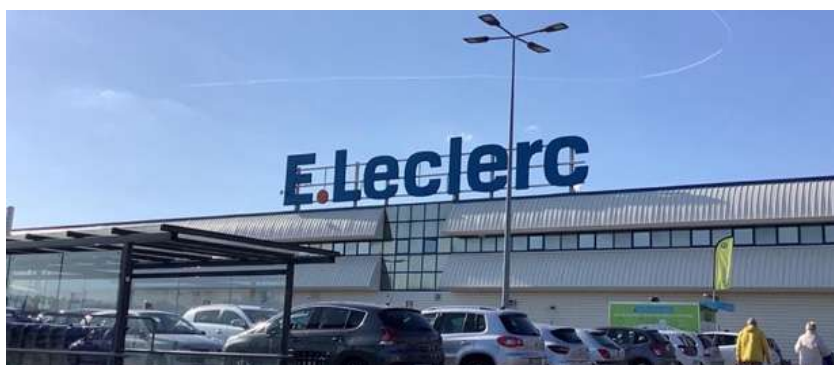
Figure 98 : Enseigne sur toiture de grand format présentant des lettres découpées, Marly (enseigne a priori conforme au RNP), printemps 2021
