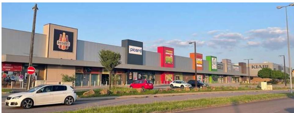
Figure 70 : Enseignes parallèles sur panneaux de fond installés en décroché de la façade en zone commerciale (enseignes a priori non conformes au RNP), Actisud Moulins-lès-Metz, printemps 2021
