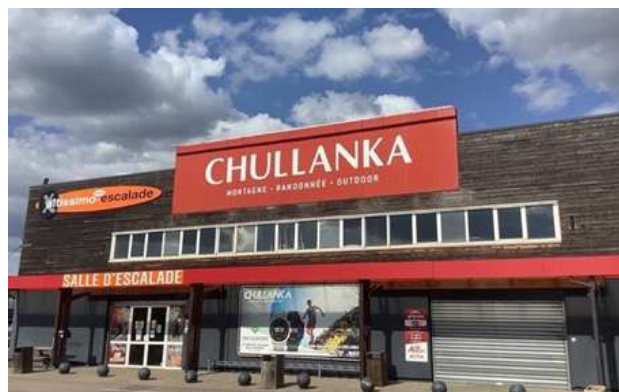
Figure 80 : Activité disposant d'une surface cumulée excessive de ses enseignes en façade (enseignes a priori non conformes au RNP), Moulins-lès-Metz, printemps 2021
