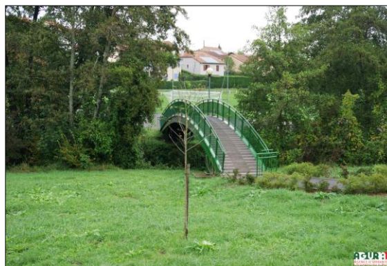
La passerelle sur le ruisseau de Vallières
