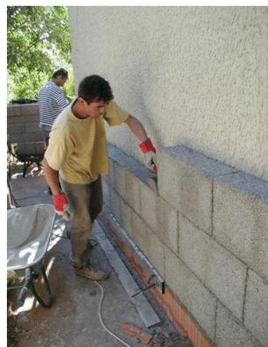
**/ Mise en œuvre de bloc de chanvre en isolant extérieur**
